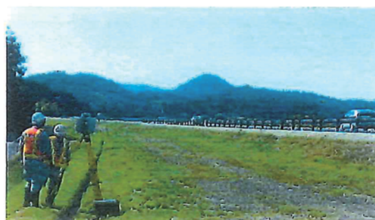
レーザースキャナによる計測状況
