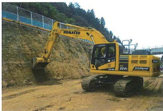
マシンコントロール技術による法面整形状況
